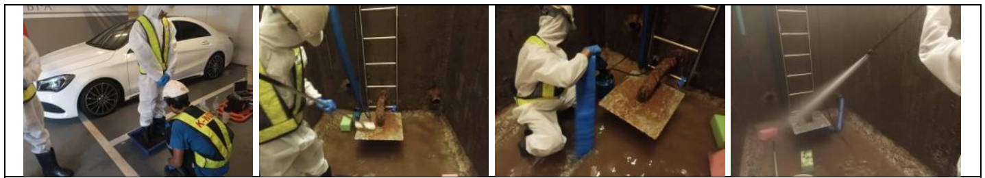
รูปที่ ผ7.21 การล้างถังเก็บน้ำใช้
