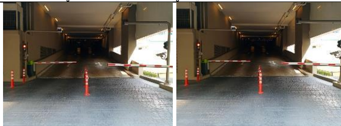
รูปที่ ๗7.13 ระบบไม้กั้นรถอัตโนมัติแบบบลูทูธ (Bluetooth Barrier Gate)
